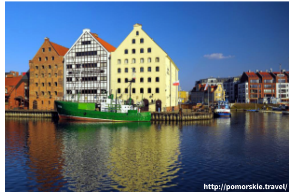
Granaries on the Ołowianka Island in Gdańsk – Seat of the National Maritime Museum Speicher auf dem Bleihof – Hauptsitz des Staatlichen Seefahrtsmuseums Gdańsk
